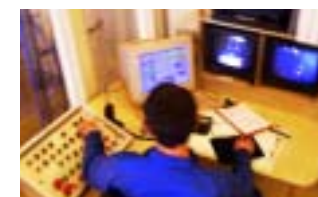
Proessen overvåkes nøye for ikke å få ukontrollerte utslipp og driftsstopp.
